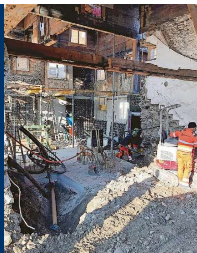
Das nicht unterkellerte Haus aus dem 17. Jahrhundert musste vollständig ausgehöhlt werden, damit der neue Innenausbau den heutigen energetischen und funktionellen Anforderungen genügt.
